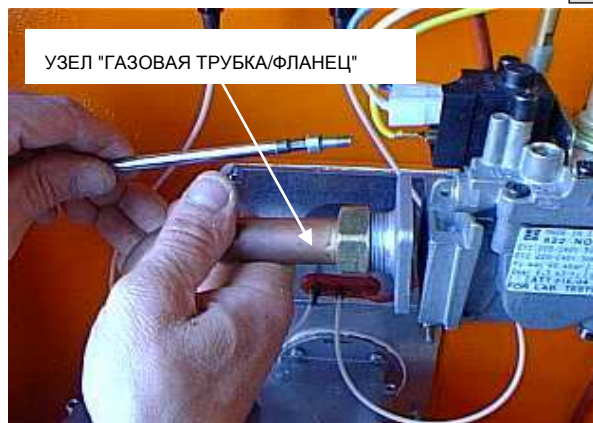
Рисунок 37 – Узел "газовая трубка/фланец"
