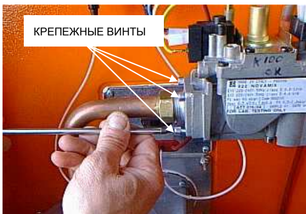
Рисунок 36 – Крепежные винты газового фланца
