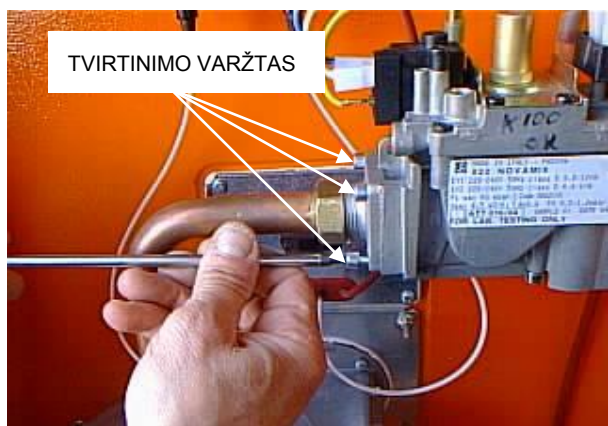
36 pav. – Dujų jungės tvirtinimo varžtai.
