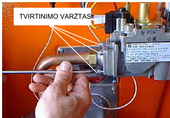
35 pav. Dujų flanšo tvirtinimo varžtai
