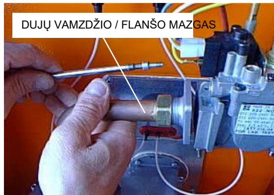
36 pav. Dujų vamzdžio / flanšo mazgas
